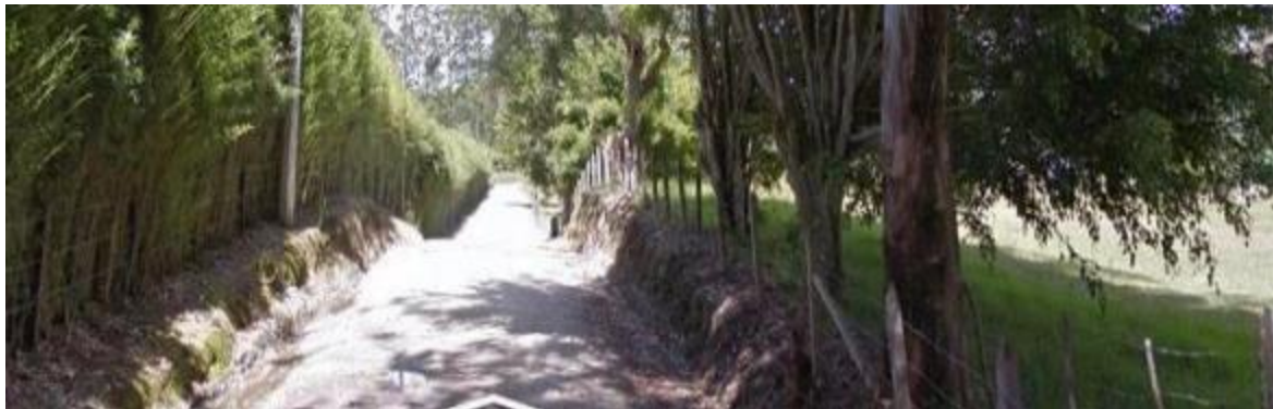
Figura 102. Estado actual vía Empanadas Caucanas – Alto Vallejo. Fuente Google Street View 2014.
