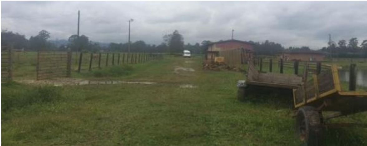
Figura 80. Estado Actual vía Mall Complex – Torres Aeropuerto – Aeropuerto JMC. 2016.
