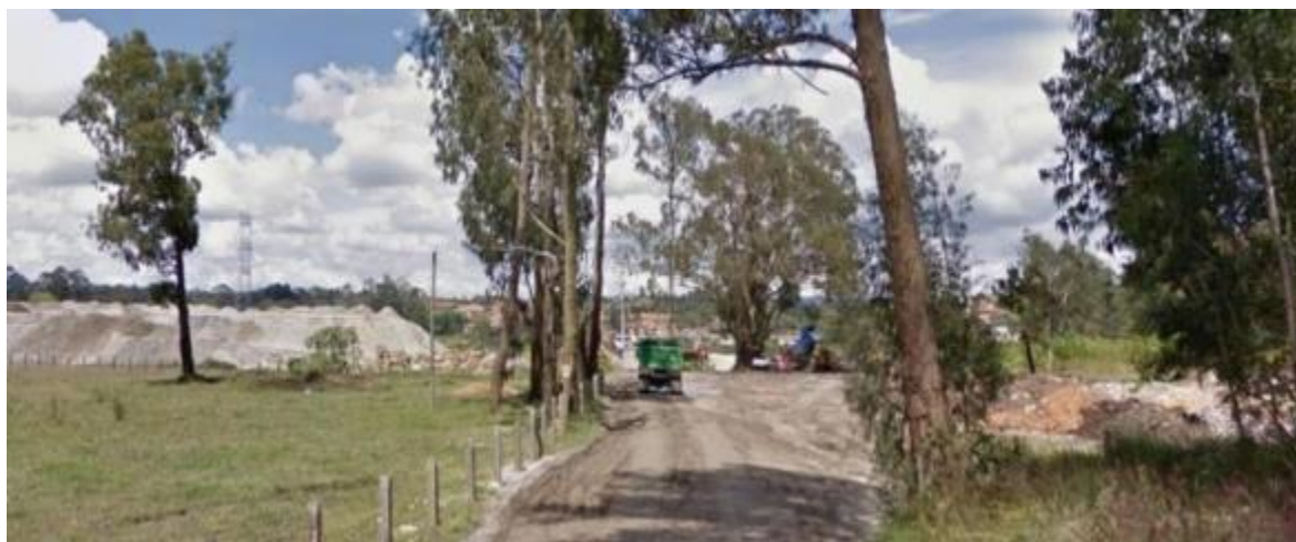
Figura 84. Estado actual vía San Antonio - Bomba De Gualanday – Comando. 2016
