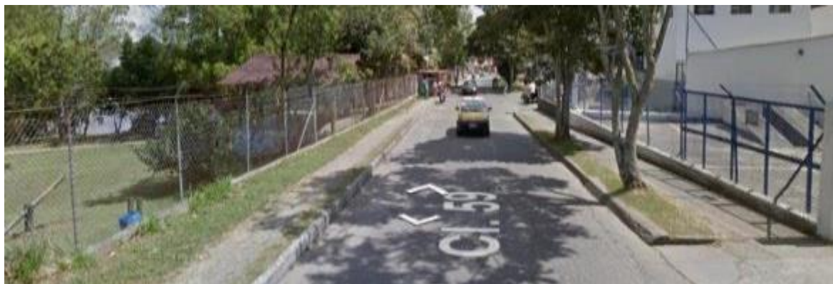
Figura 97. Estado actual vía Cruce Calle 59 con Carrera 47 – Laureles – Fontibón. Fuente Google Street View 2014.
