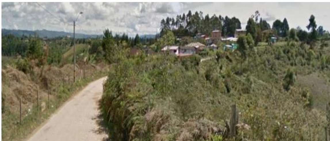
Figura 143. Estado actual vía El Tanque - Fontibón – Postobón. Fuente Google Street View 2014.
