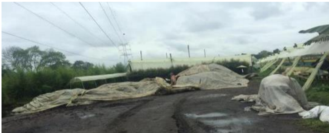
Figura 70. Estado actual vía Jumbo – Vía Las Torres – Comando Llanogrande. 2016
