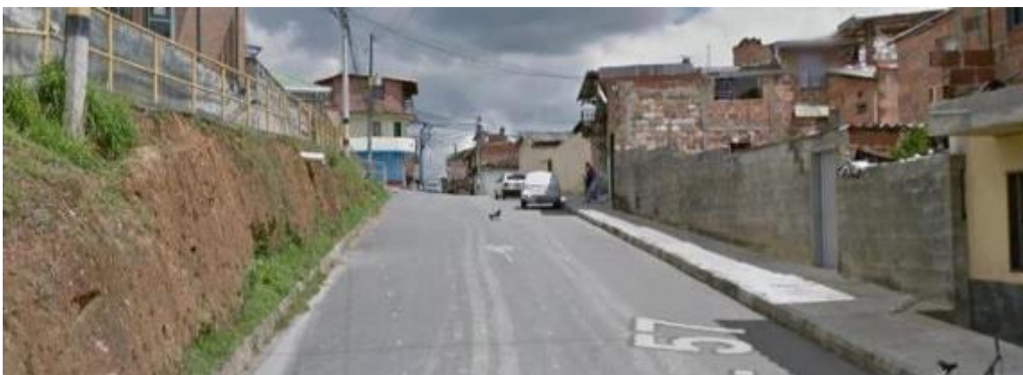
Figura 129. Estado Actual vía Carrera 57 Desde Vía La Poceta Hasta Calle 52. Fuente Google Street View 2014.
