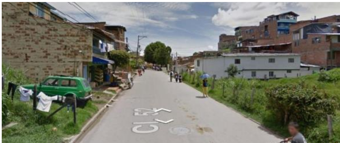
Figura 126. Estado actual vía Calle 52 desde Anillo 1 hasta Quebrada Arriba. Fuente Street View 2014.
